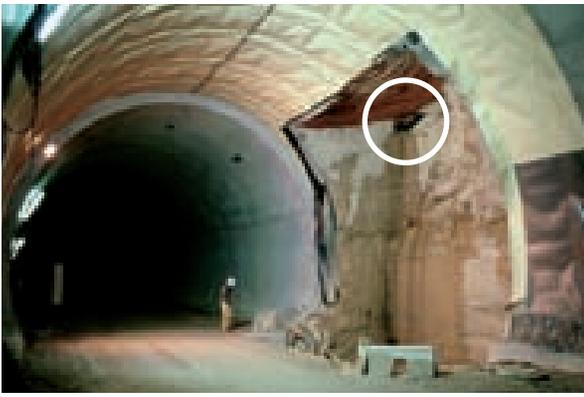
Höhle (im Kreis), die beim Vortrieb eines Tunnels der Autobahn A5, Neuenburg – Yverdon angeschnitten wurde. Bei Hochwasser strömt mehr als 1 Kubikmeter Wasser pro Sekunde aus diesem Gang!
